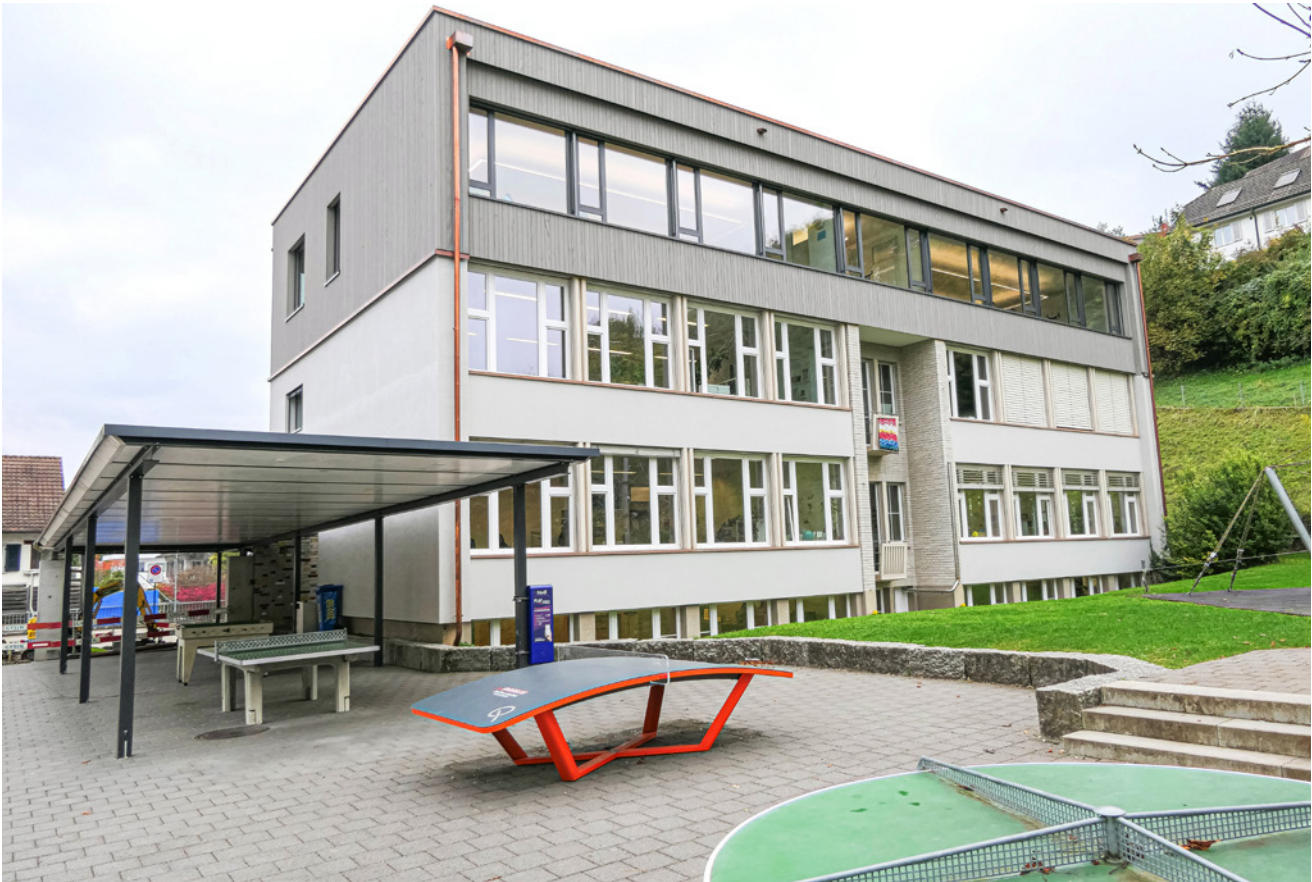
Im neuen Stockwerk wurden zwei Klassenzimmer und ein Gruppenraum geschaffen.
